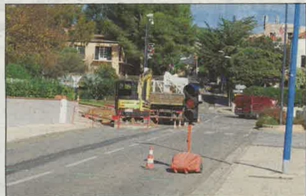
Circulation alternée pendant les travaux de rénovation électrique à la Favière. Ici, avenue des Lauriers.
